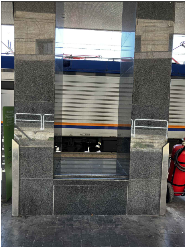
● Seduta banchina Area E Seduta posta tra i pilastri della pensilina Binario 1-2 Est.
