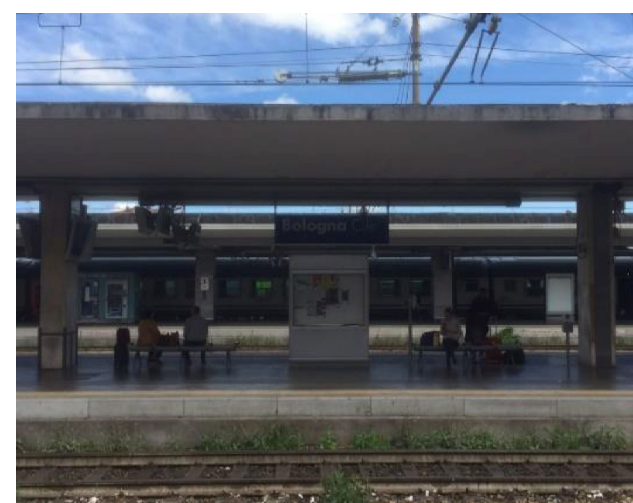
Bin. 3/4 centrale (Foto2)
